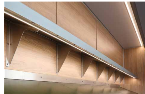
LED-Beleuchtung unterhalb des Regals
