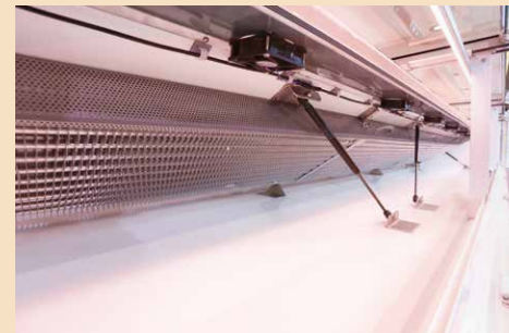
Thekenbett mit umgeklapptem Verdampfer
