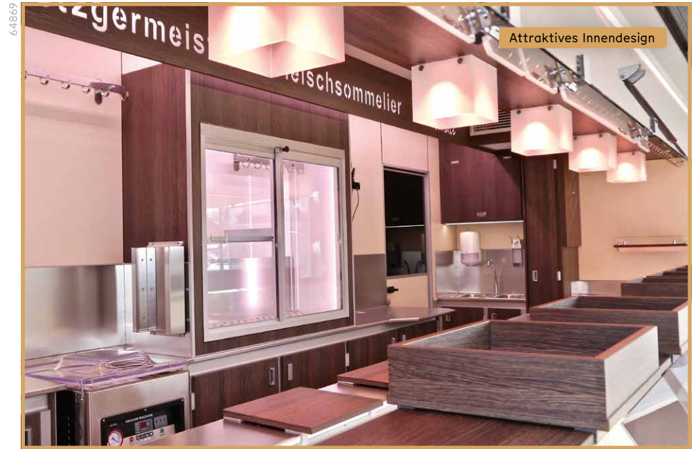
Sicht-Kühlschrank mit isolierten Schiebetüren auf der Arbeitsfläche
